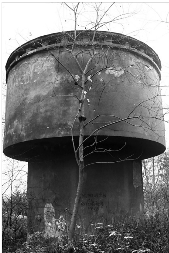
Relikty dawnej infrastruktury wodociągowej, nieczynny zbiornik wyrównawczy dla osiedla domów przy ul. Robotniczej, fot. P. Kardyś
