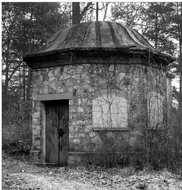
Przepompownia ścieków dla dawnej oczyszczalni PFA, ul. Struga, stan obecny, fot. P. Kardys
